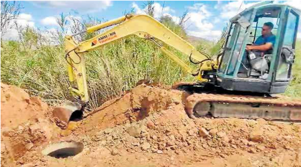
Una máquina excavadora para descubrir la avería de la gran tubería de Cártama. SUR
