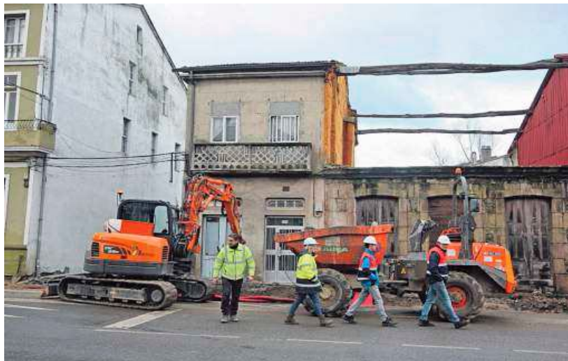
Obras de sustitución de la antigua tubería de fibrocemento en la calle Morín. CARLOS CORTÉS
